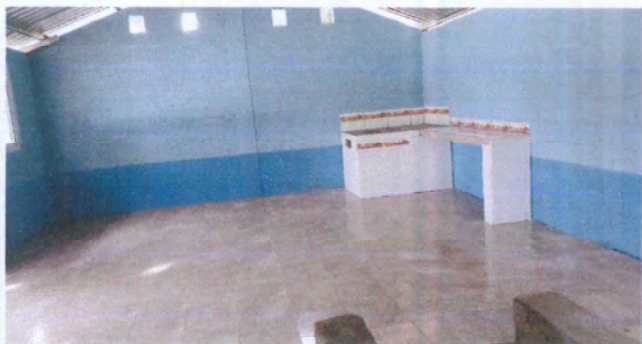
Foto1: Piso cerámico instalado
