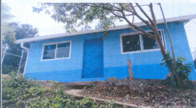
Foto 3: Puerta, ventanas instaladas, y aplicación de pintura exterior e interior finalizadas
