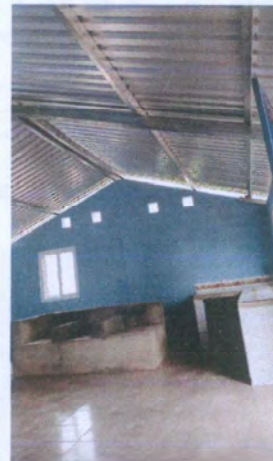
Foto 2: Banco de trabajo, estructura de techo pórtico, lámina troquelada calibre 26 instalada.
